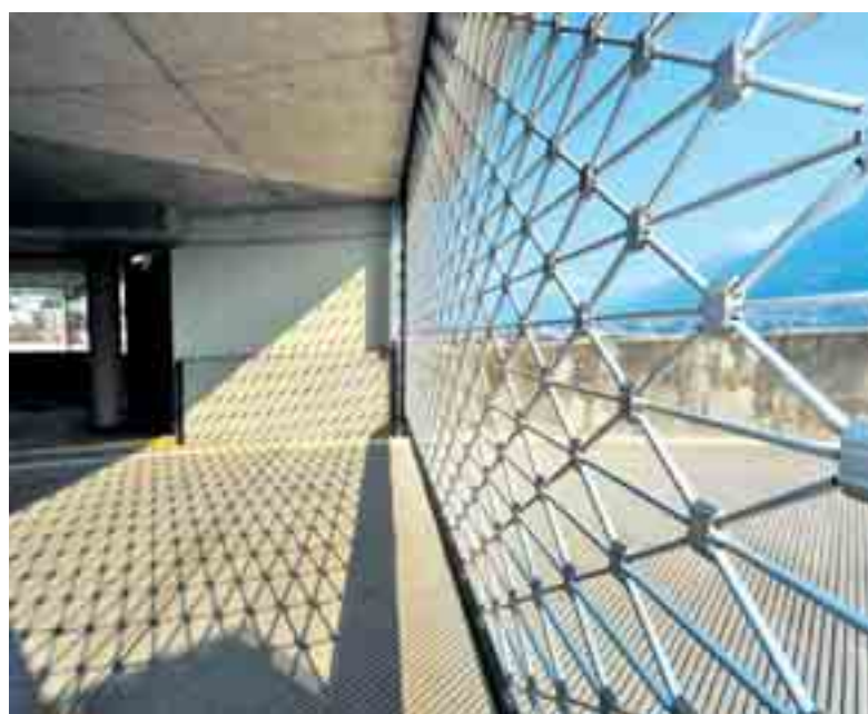
Le grate con cui sono state sbarrate le aperture dei piani alti. (fotogonella)
